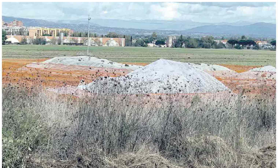
L'area di via dei Giardini interessata dal presunto sversamento di gasolio
