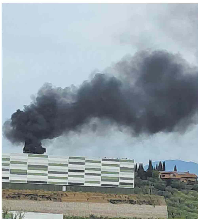
Passo Corese Fumo nero ieri mattina nel polo logistico per l'incendio partito dai pannelli fotovoltaici sopra un capannone
